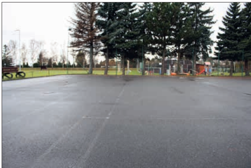
Hřiště v Kostelci (u dětského a fotbalového hřiště)
